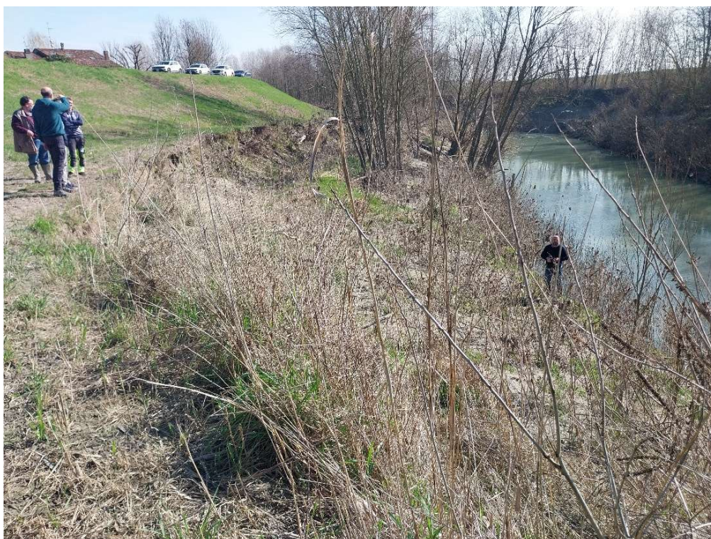
Figura 3 - Erosione in sponda sinistra stante 30 a valle della difesa esistente
