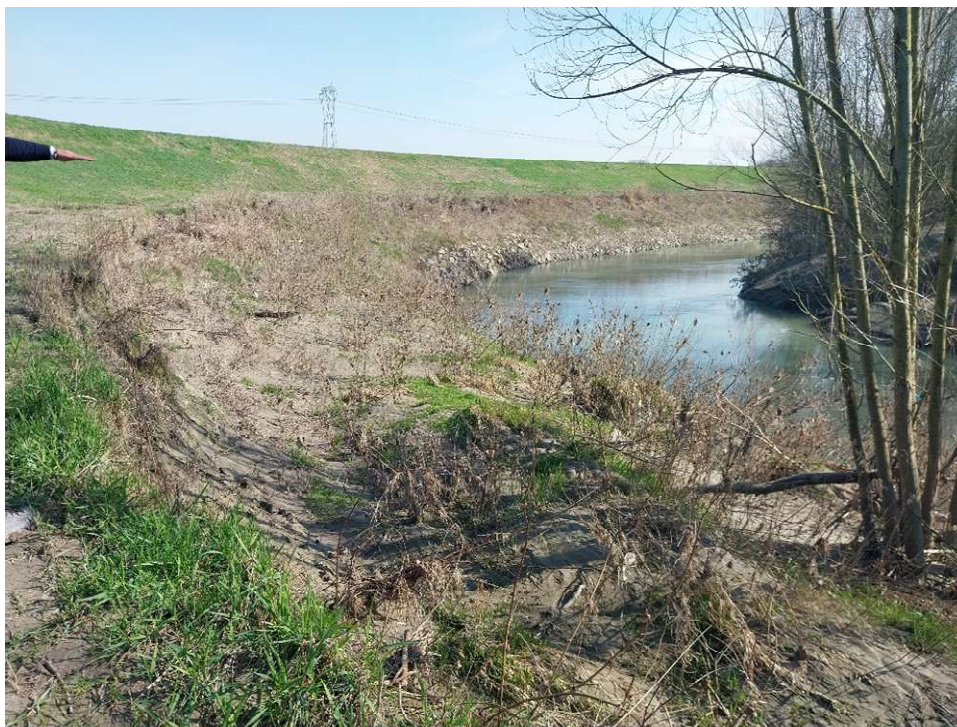
Figura 2 - Erosione in sponda sinistra stanti 30 a monte difesa esistente
